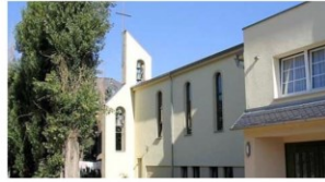
St. Antonius Chemnitz Erfenschlager Straße 27 09125 Chemnitz
